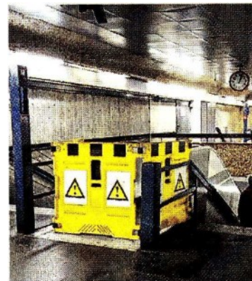
Scala mobile guasta alla stazione Flaminio (foto TOIATI/GIANNETTI)
